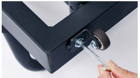
32. Tag pakningen og skru hjulet på og spænd det med unbrakonøgle.
